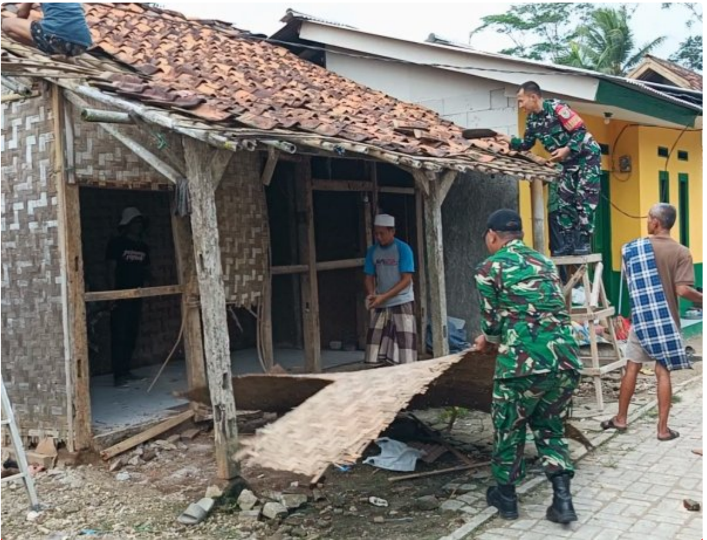
Pembongkaran Rumah Bapak Narmin
